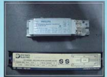
บัลลาสต์แบบแกนเหล็ก (บน) ถูกแทนที่ด้วยบัลลาสต์แบบอิเล็กทรอนิกส์ (ล่าง)
