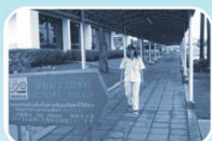
ทางเดินภายในโรงงาน ที่ใช้อิฐบล็อกที่ทักขยะสิ่งแวดล้อม
